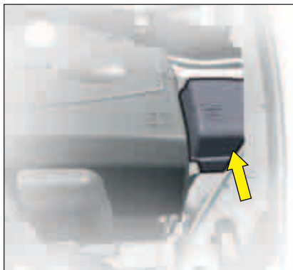
Zekeringen in de motorruimte
